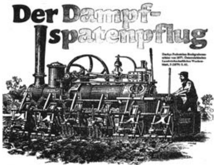
Figura 1: El arado a vapor de palas del año 1877. La ancha máquina pedestre de cavar de Derby de 1877 (Semnario Agrícola Austriaco, 5 (1879), p.61)
